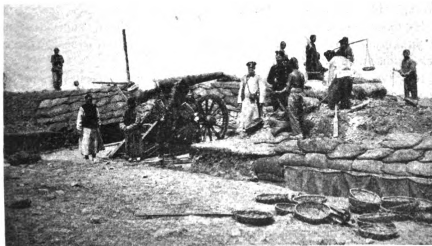
Постройка заредутной батареи.
