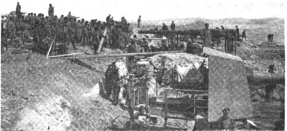
Работы на батарее № 22; командиръ батареи капитанъ Вамензонъ; вдали виднѣются Зеленя горы и бухта Лунвантанъ
