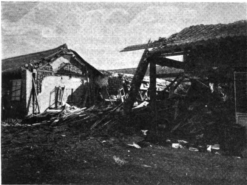
Разрушеніе, произведенное 11-дюймовымъ снарядомъ.
