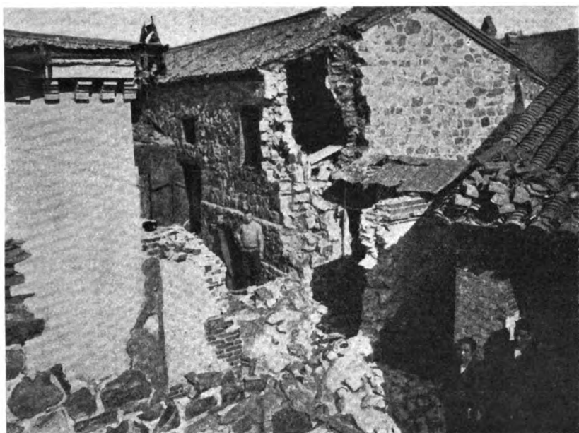
Разрушенія, произведенныя 11-дюймовымъ снарядомъ.
