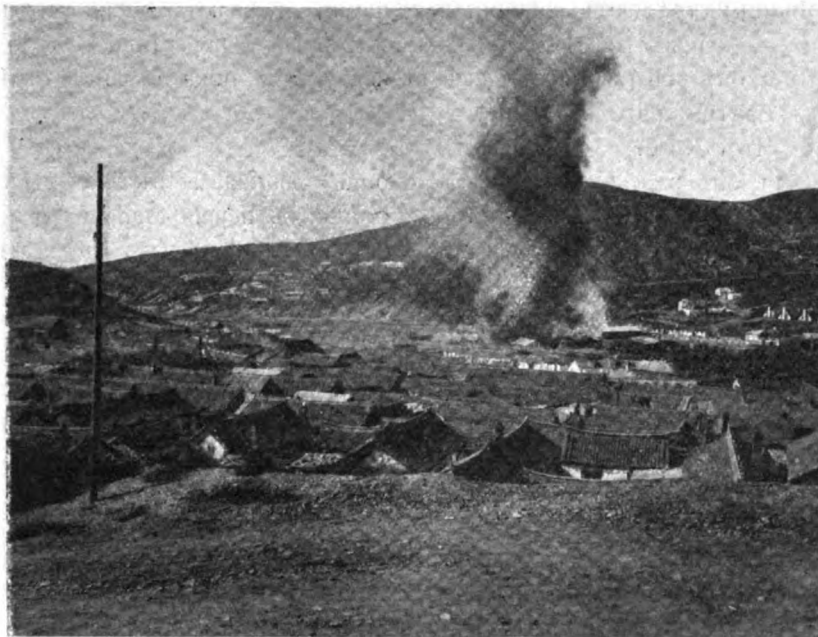
Пожаръ инженернаго склада близъ Цирковой площади.
